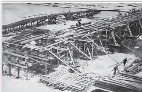
Строительство нового Тезикова моста через р. Цну в Тамбове. 1932 г.
