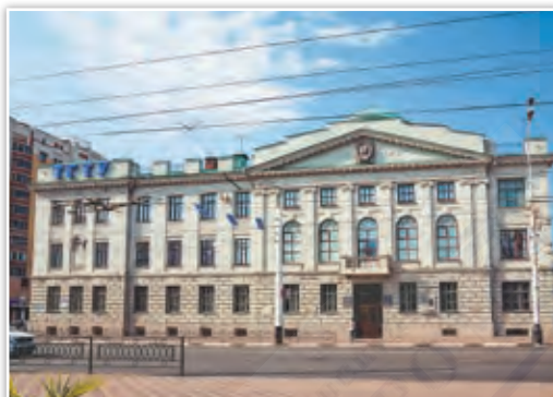
Здание Тамбовского государственного технического университета. Фото С. Лаврентьева
