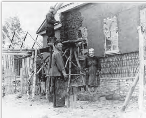
Строительство дома в Котовске. Начало 1950-х гг.
