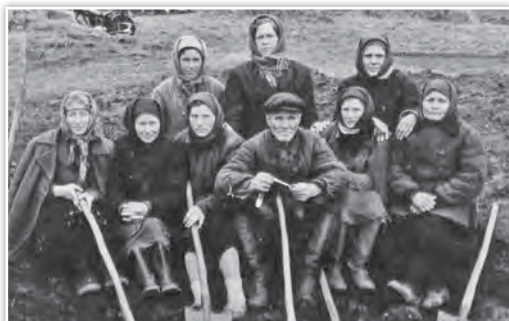
Бригада землекопов в с. Кулевча Инжавинского района. 1947 г.
