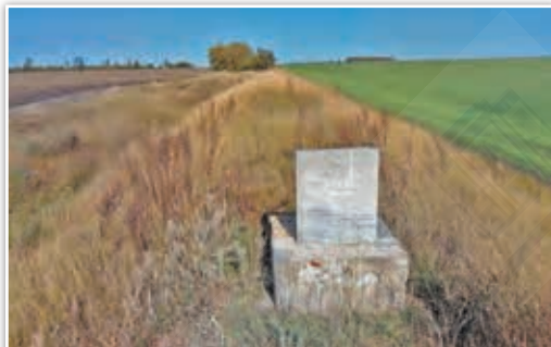
Фрагмент остатков Тамбовского вала. Современный вид
